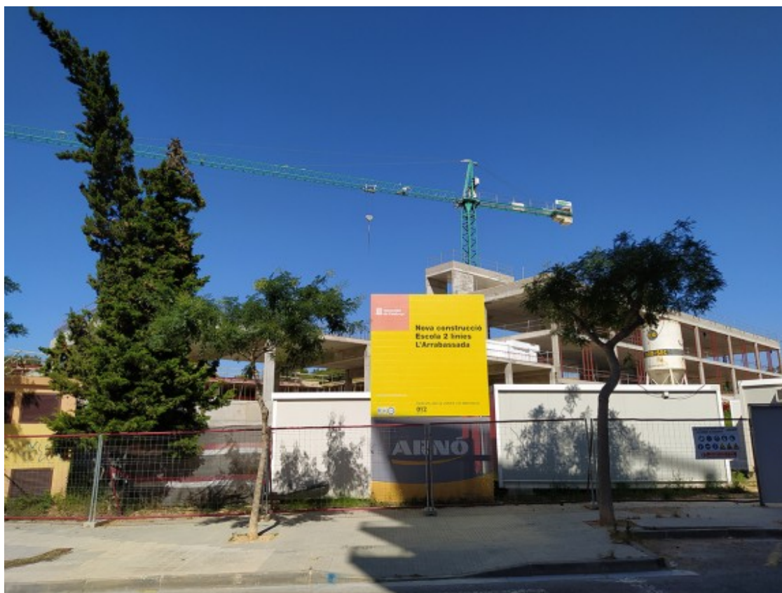
L'Escola Arrabassada, en construcció, en una imatge d'arxiu. Foto: Josep M. Llauredó
