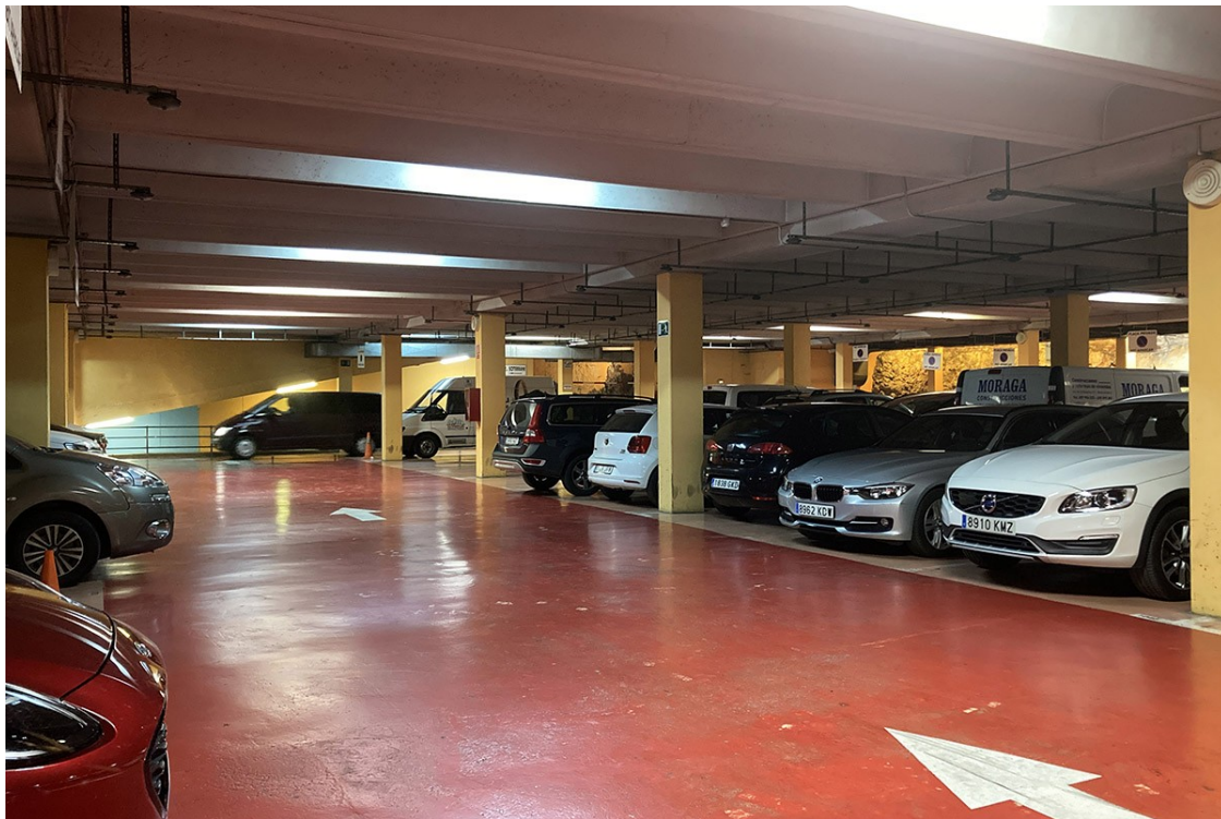
L'aparcament soterrat de plaça Corsini. | David Oliete
