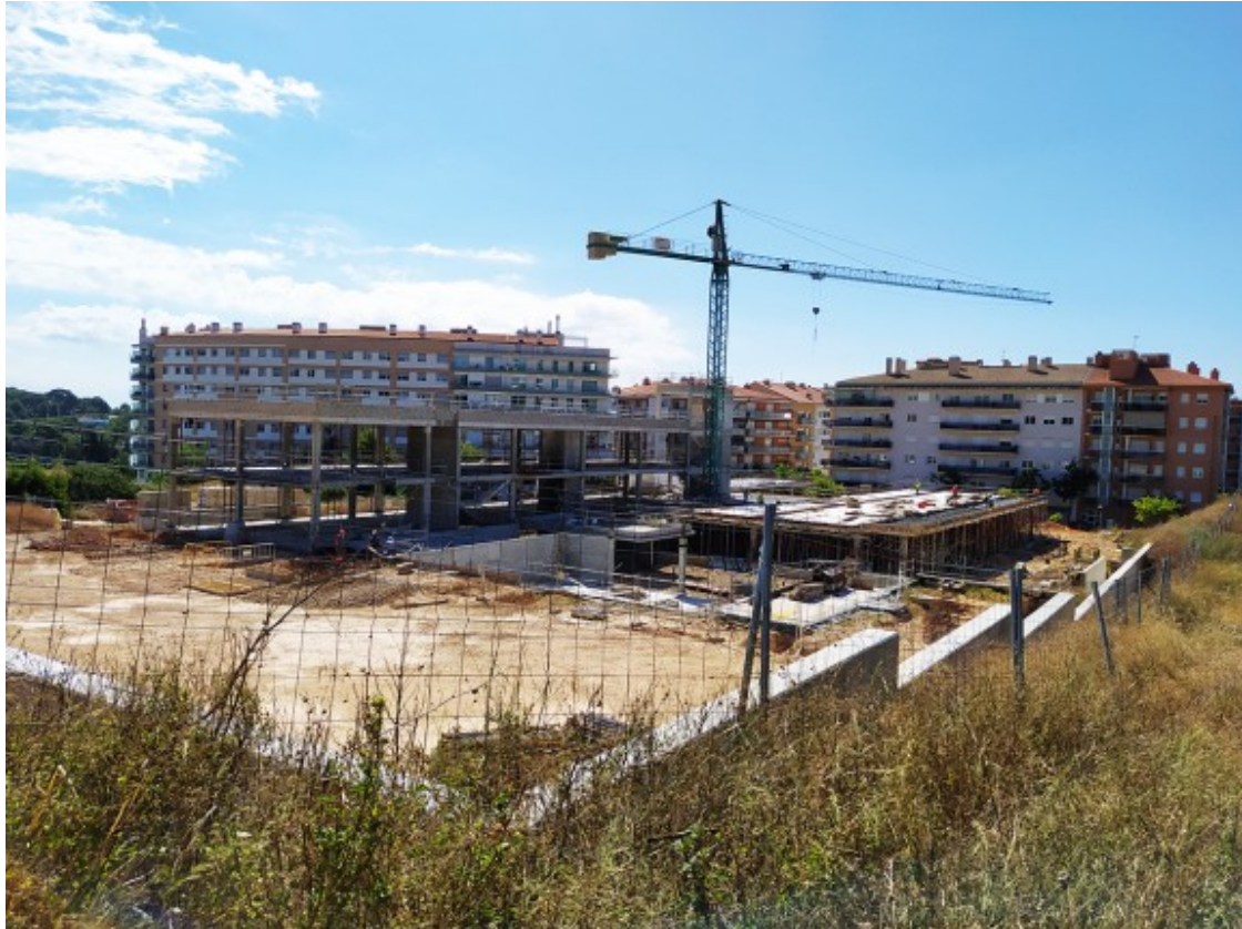
Les obres de l'Escola de l'Arrabassada, des de les Parcel·les Iborra. Foto: Josep M. Llauredó
