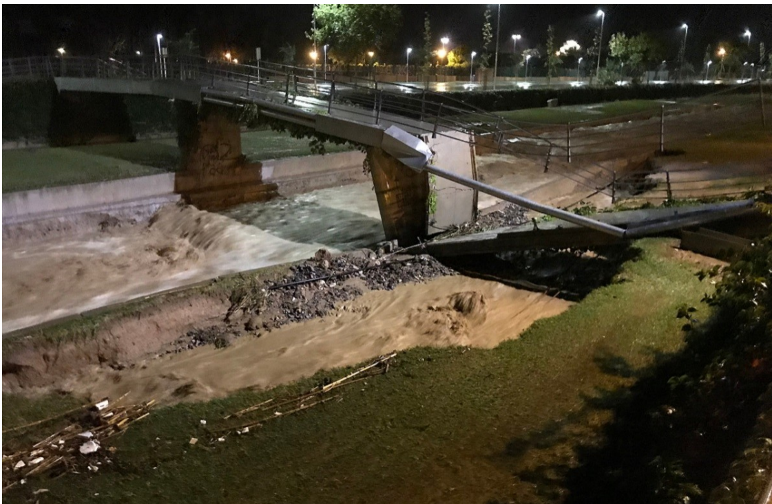
La passarel·la ensorrada de la riera d'Alforja de Cambrils | ACN
