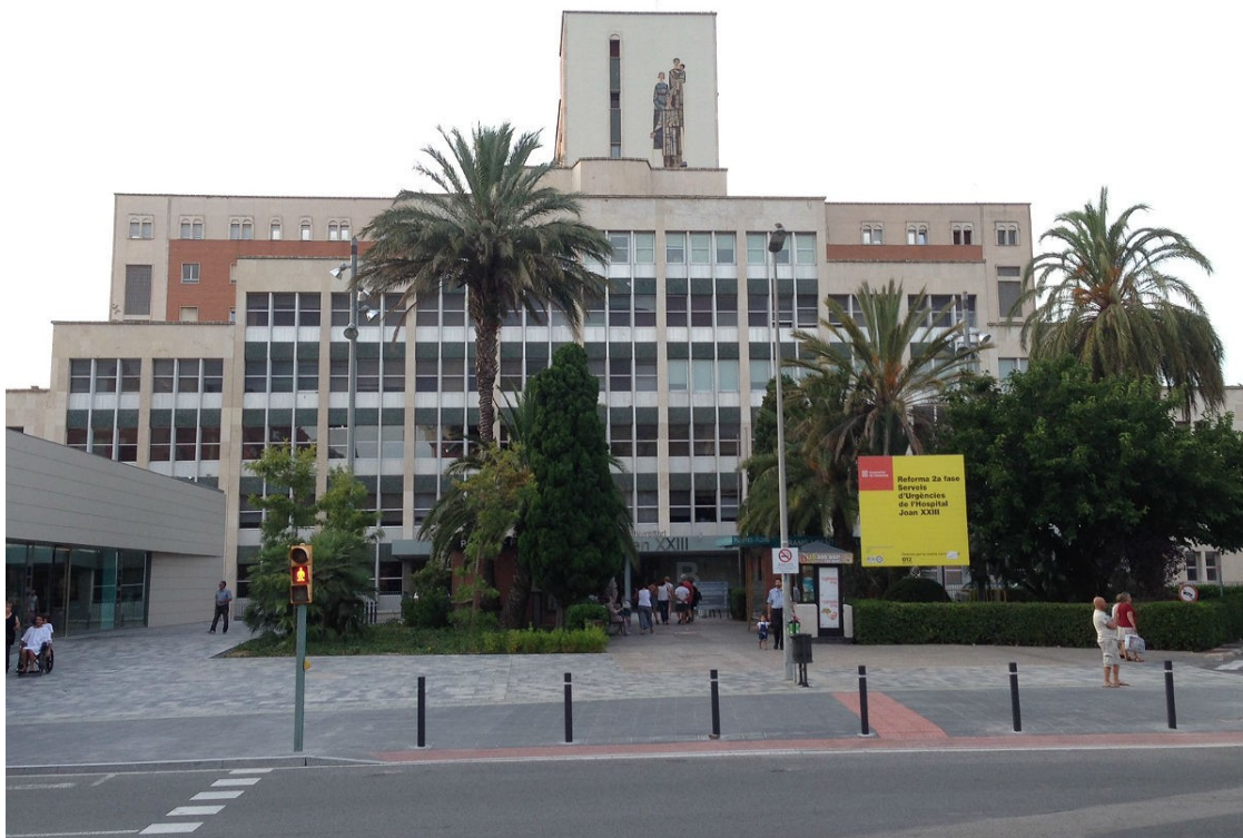
Façana de l'Hospital Joan XXIII de Tarragona | Jonathan Oca
