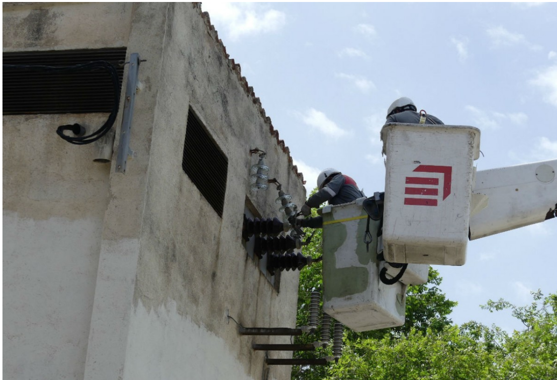
Els operaris treballant per restablir el subministrament | Jonathan Oca
