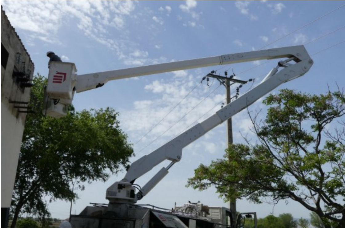
Operaris treballant per restablir el servei elèctric Foto: Jonathan Oca
