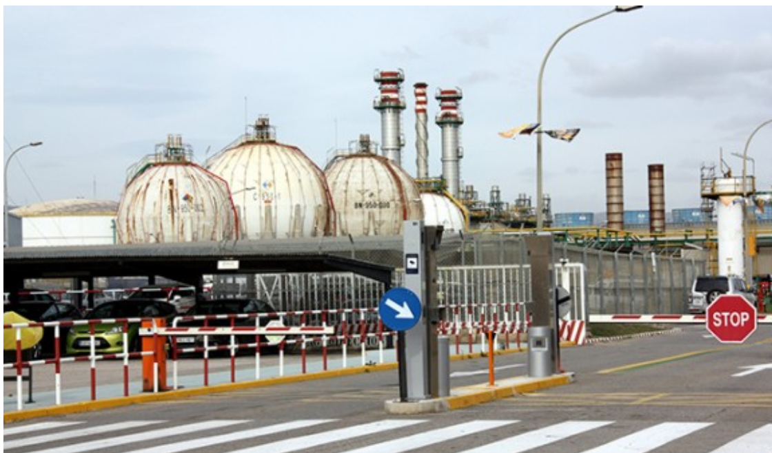
Naus del polígon químic de Repsol, al polígon nord de Tarragona. Foto: delCamp.cat.
