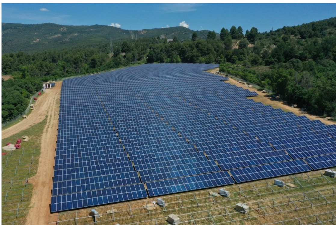
Imatge aèria d'una planta fotovoltaica prop de la presa de la Talarà | Visiondrone
