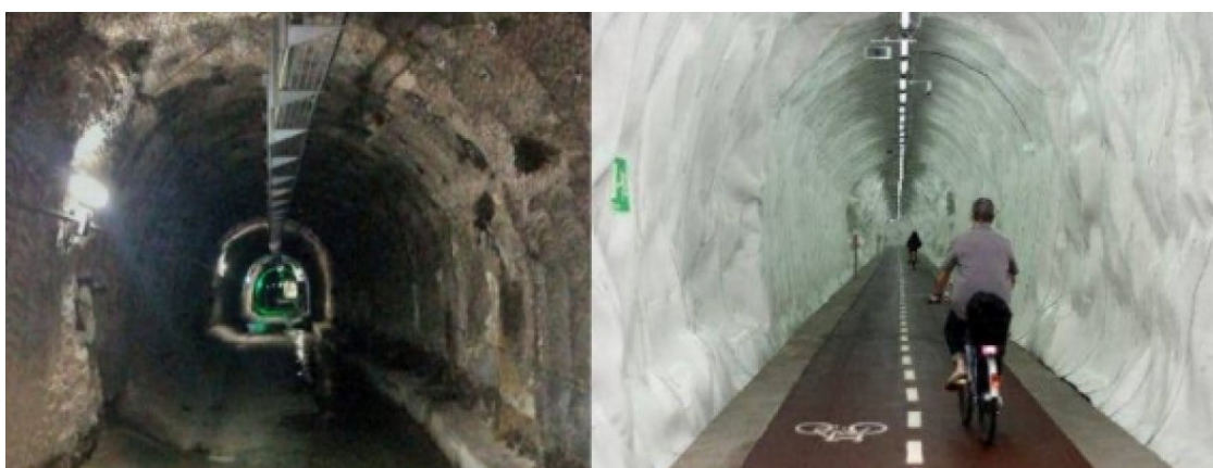
Imatge de l'entrada d'incorporació del carril bici als Túnels de Vallvidrera | BikeVidrera
