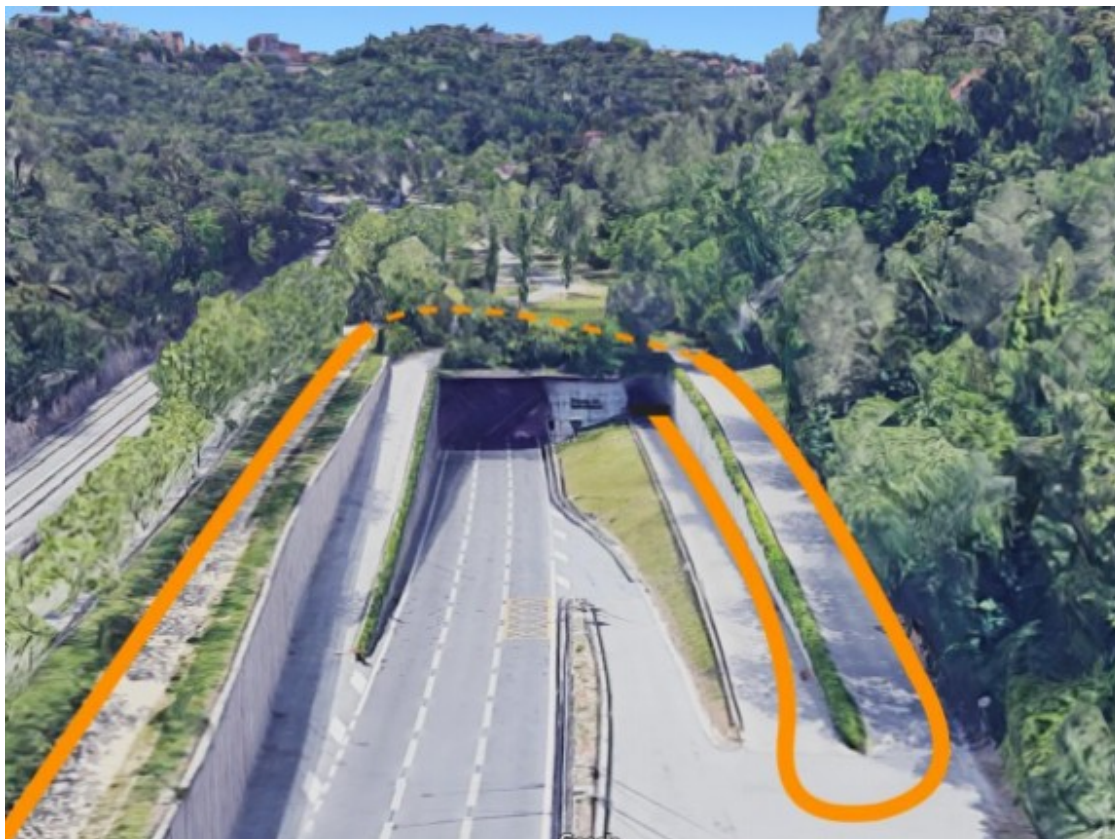
Entrada del túnel de serveis per la boca nord Foto: BikeVidrer
