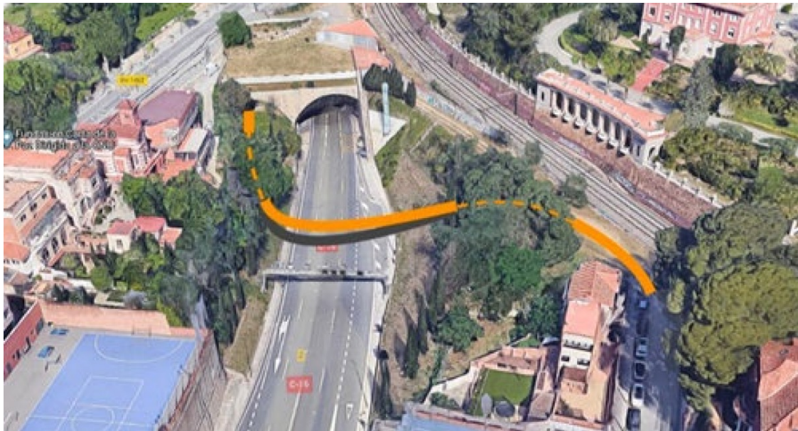
Imatge de l'entrada d'incorporació del carril bici als Túnel·ls de Vallvidrera | BikeVidrera
