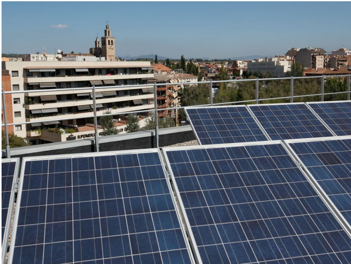
Imatge de les plaques solars instal·lades al sostre de l'Ajuntament de Sant Cugat | Aj. Sant Cugat
