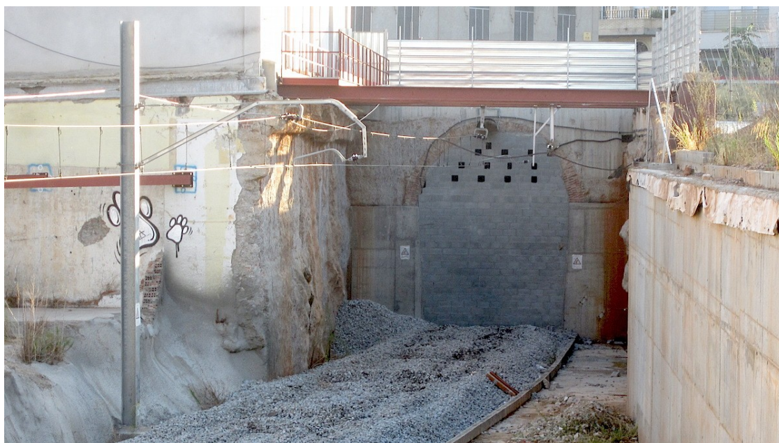
El túnel de Sabadell Rambla, tapiat | Albert Segura
