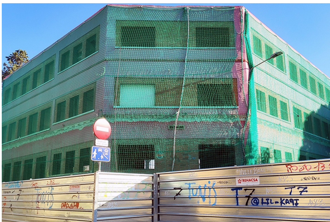
L'estat en el qual es troba l'edifici | Albert Hernández
