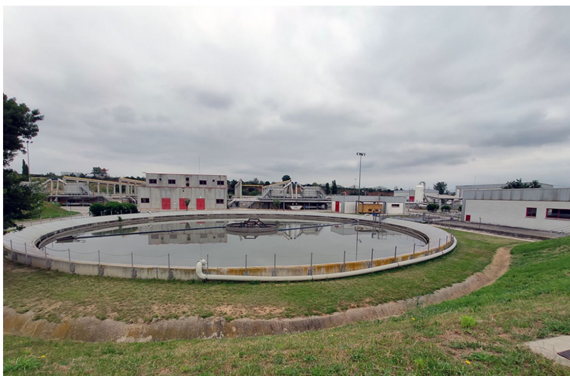
La Depuradora de Riu-sec, a Sabadell | Albert Hernández
