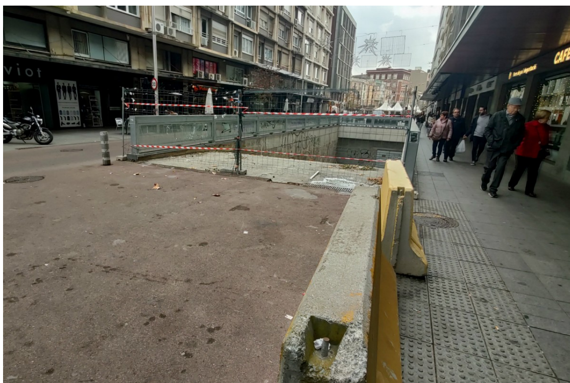
L'estat actual de l'entrada a l'aparcament del Passeig | Albert Hernández
