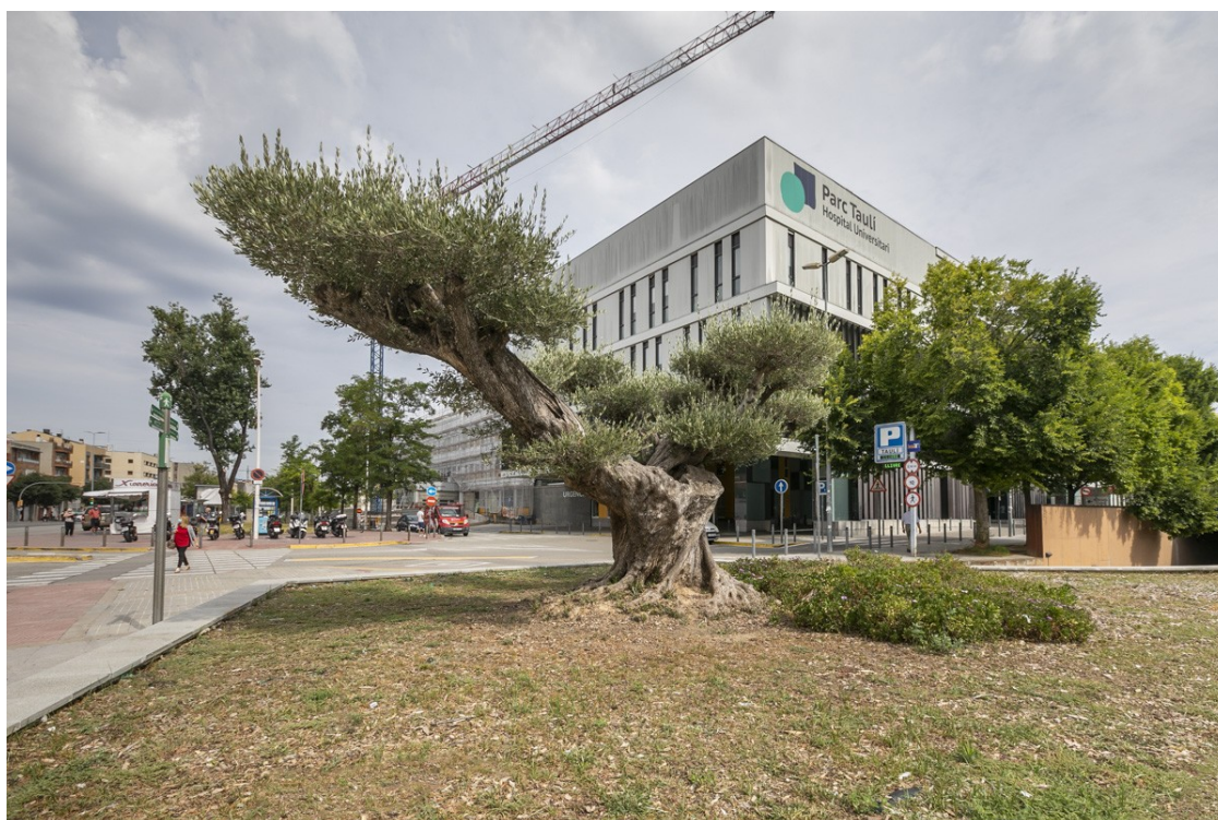
L'Hospital Parc Taulí | Juanma Peláez
