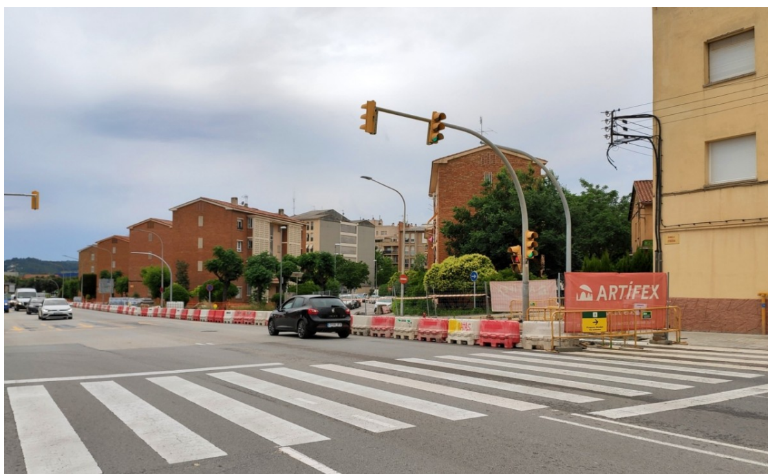
Les obres a la Rambla Ibèria | Albert Hernández
