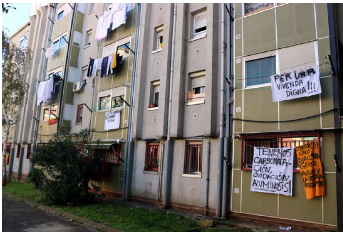
Un dels edificis afectats de Merinals | ACN
