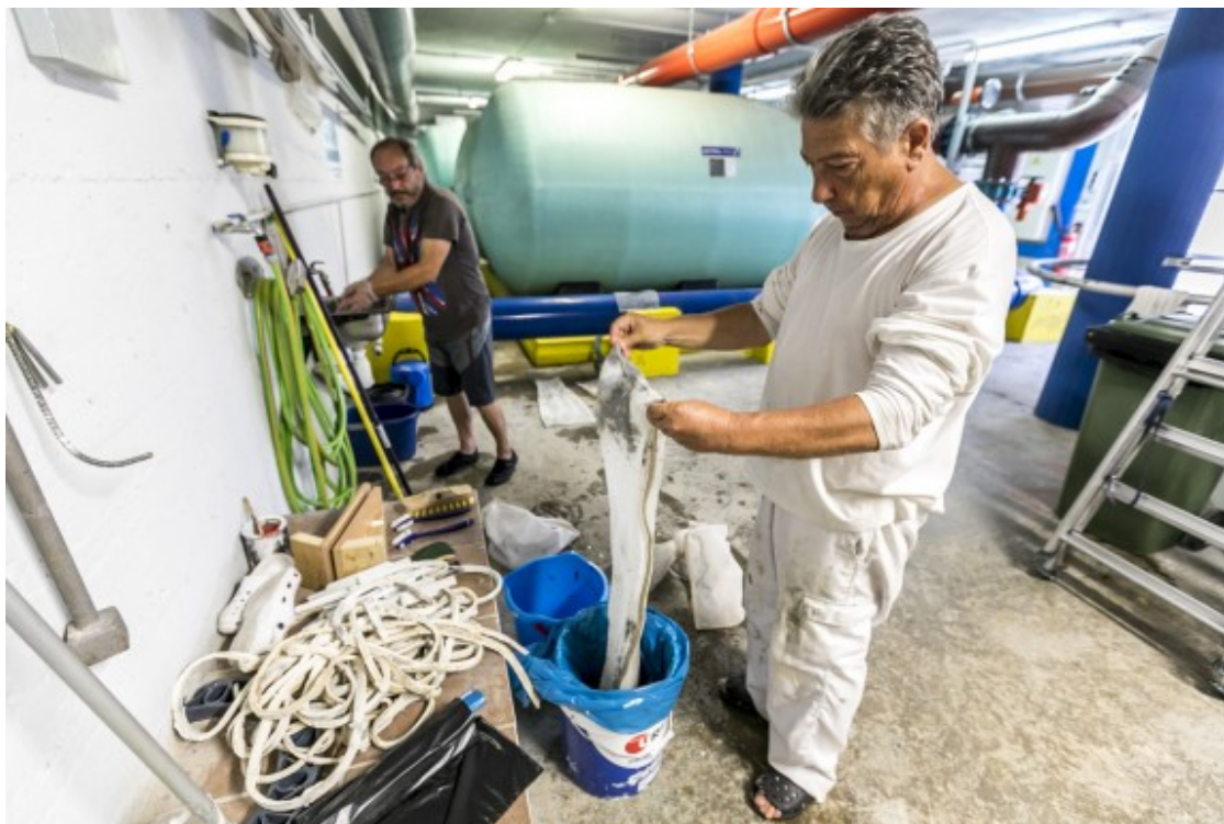
Cada dia es comprova que els filtres i tot l'instrumental estigui a punt. Foto: Juanma Peláez
