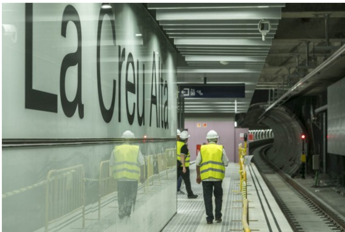
L'andana de la futura estació de FGC Creu Alta Foto: Juanma Peláez
