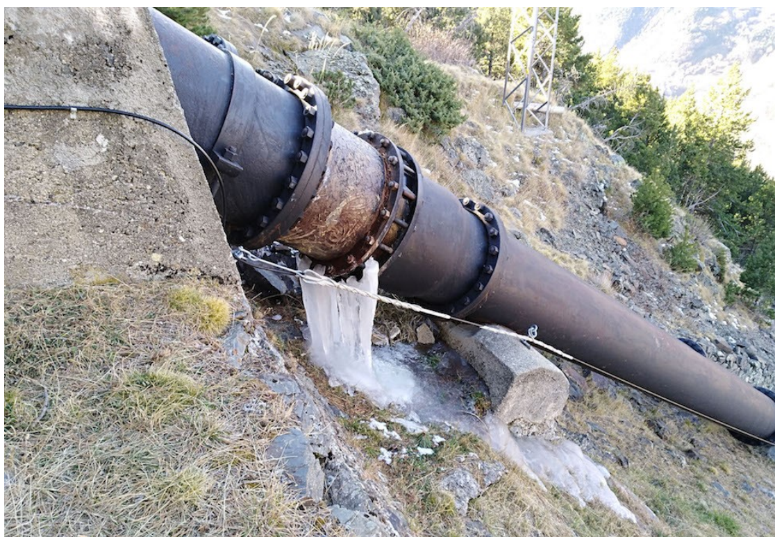
Detall de la fuga en una de les canonades del salt d'aigua de Capdella | CUP Vall Fosca
