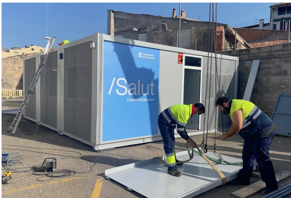
Tècnics instal·lant el mòdul a Oliana | Salut
