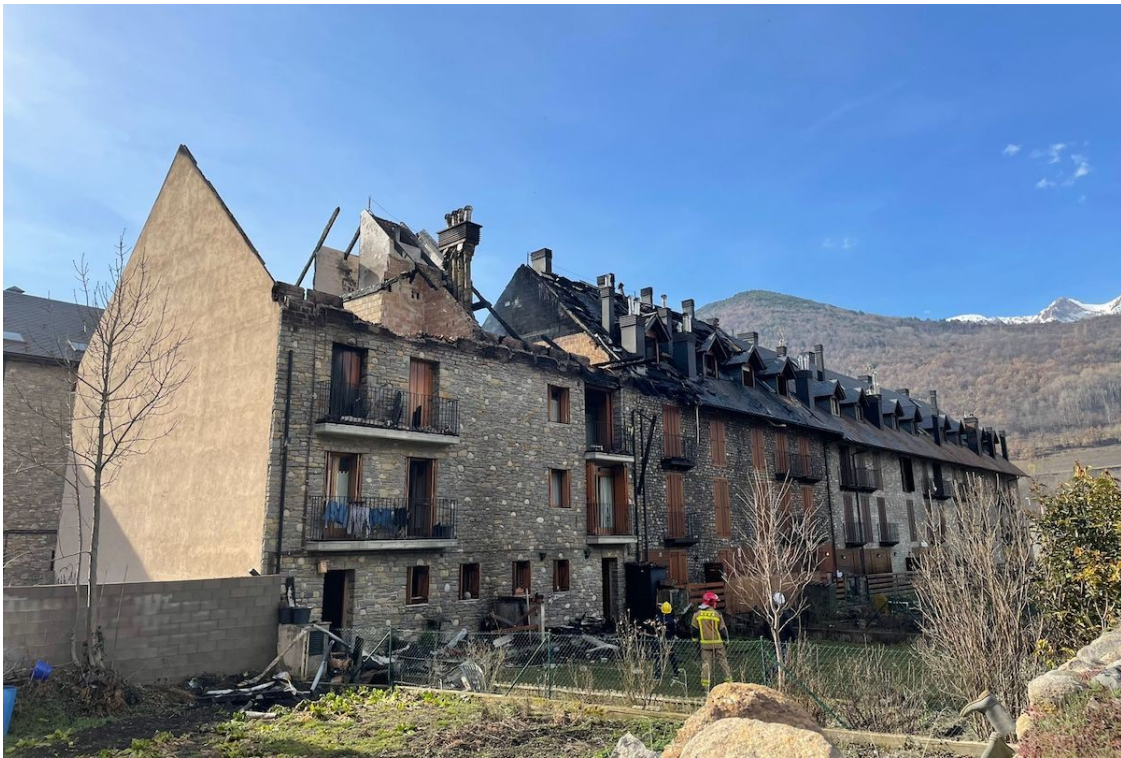
Estat en què ha quedat l'edifici després de l'incendi | Pere Ticó
