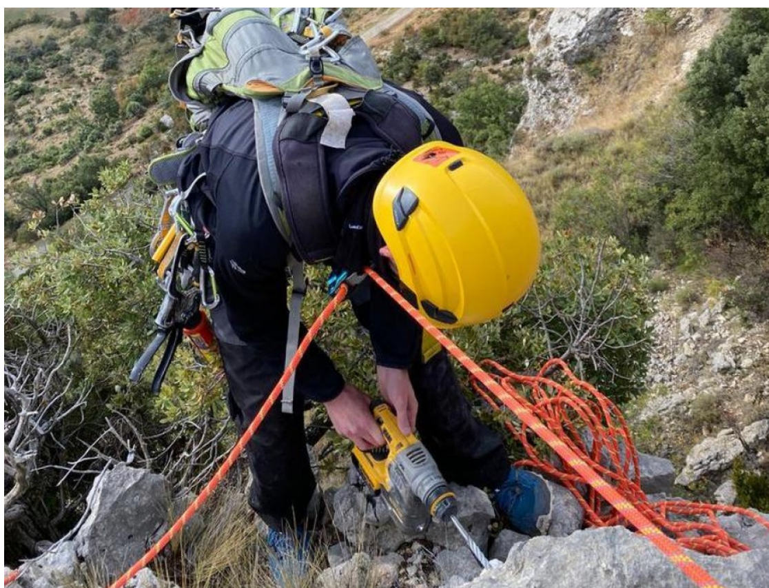
Un tècnic instal·lant un sensor a la roca prop de la LV-9124 | Ajuntament
