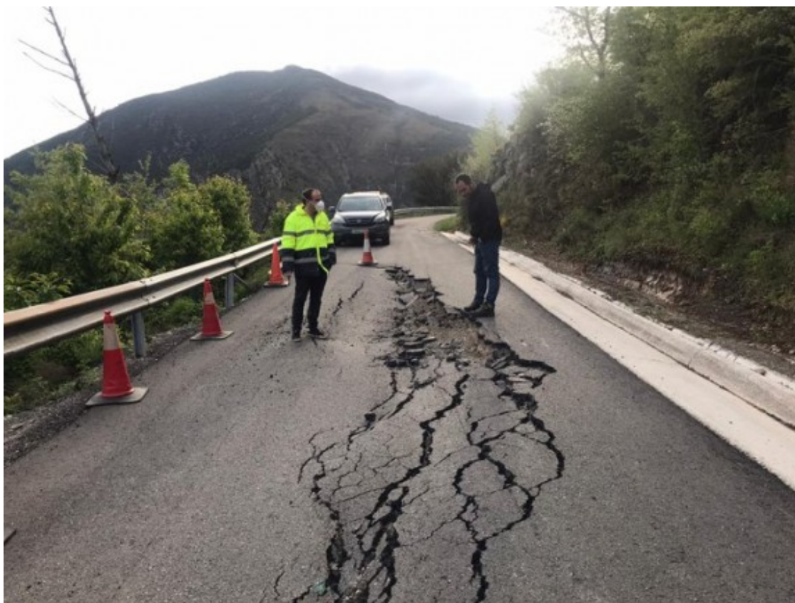
Fotografia del tram malmès i deteriorat a causa de les últimes pluges Foto: Ajuntament
