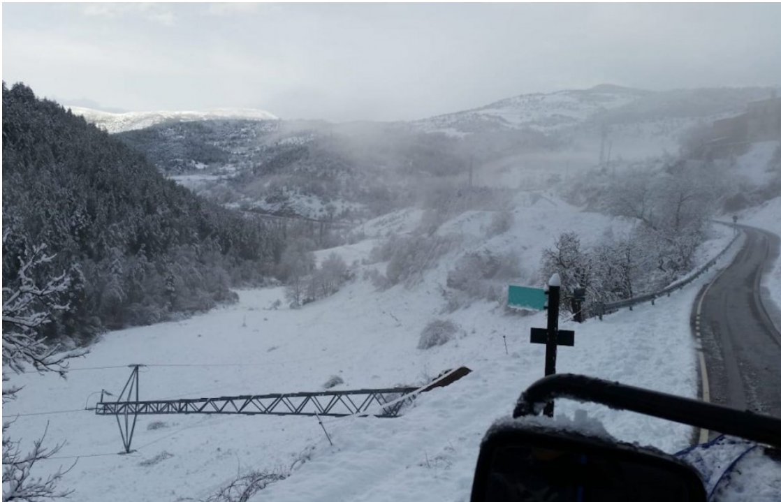
Una torre caiguda a la zona de la vall de la Vansa, a l'Alt Urgell | ACN
