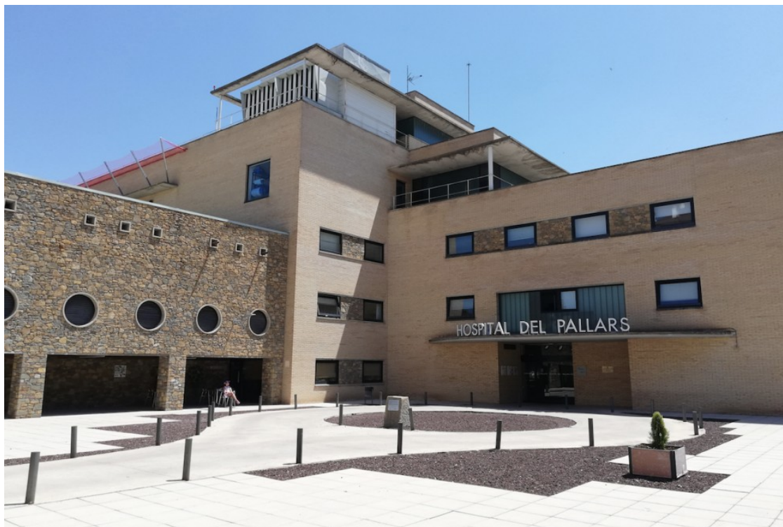
Imatge de la façana principal de l'Hospital Comarcal del Pallars | GSS
