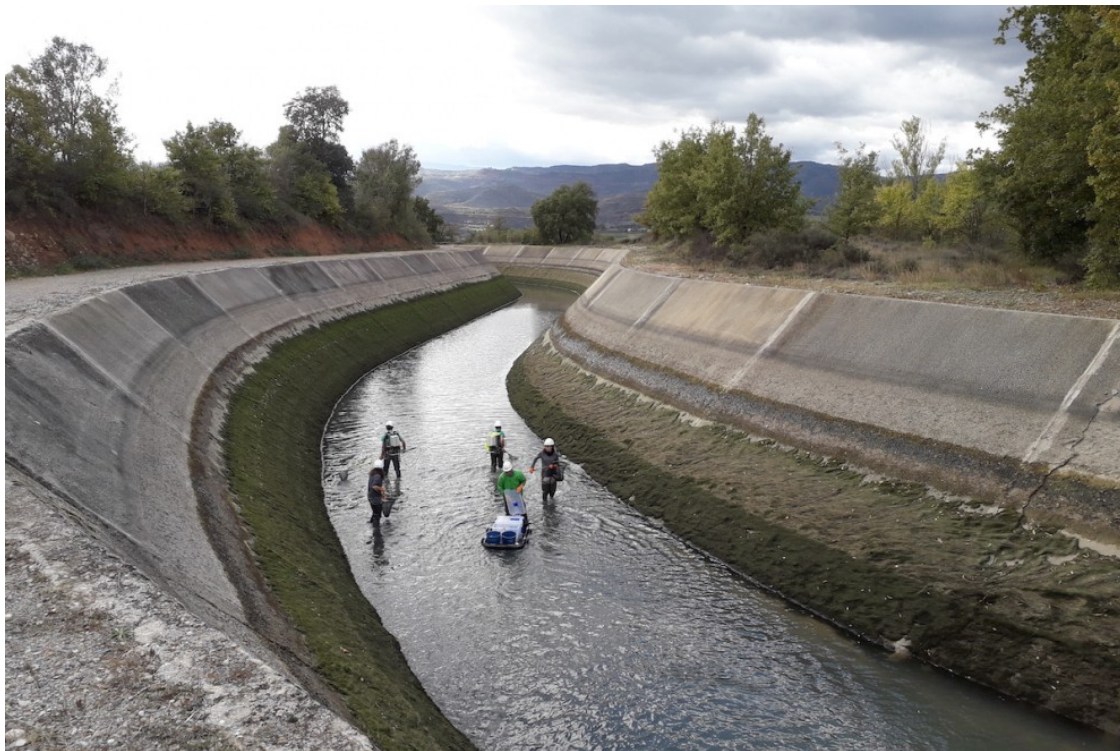
Imatge de les tasques de manteniment al canal de Gavet | Endesa
