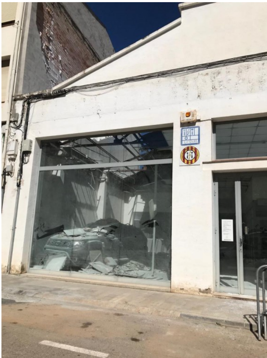
Imatge general del taller i de l'arrebossat que ha cedit. Foto: Josep Fernàndez
