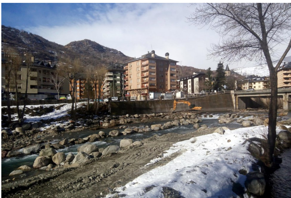
Imatge del tram en obres amb una màquina treballant al fons. | Rius amb Vida
