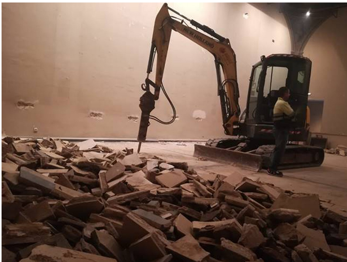
Obres a l'Illa de la Pietat | Aj. de Vic
