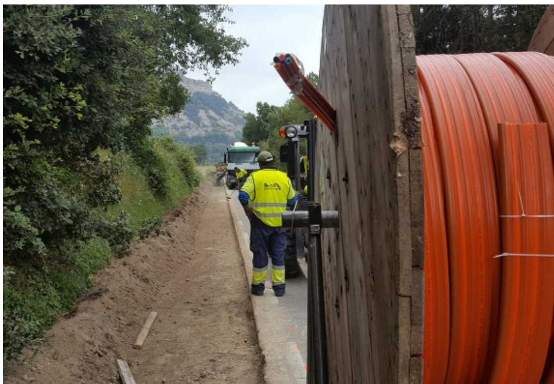
El tritub per a fibra òptica a la xarxa de carreteres. Foto: Diputació de Barcelona
