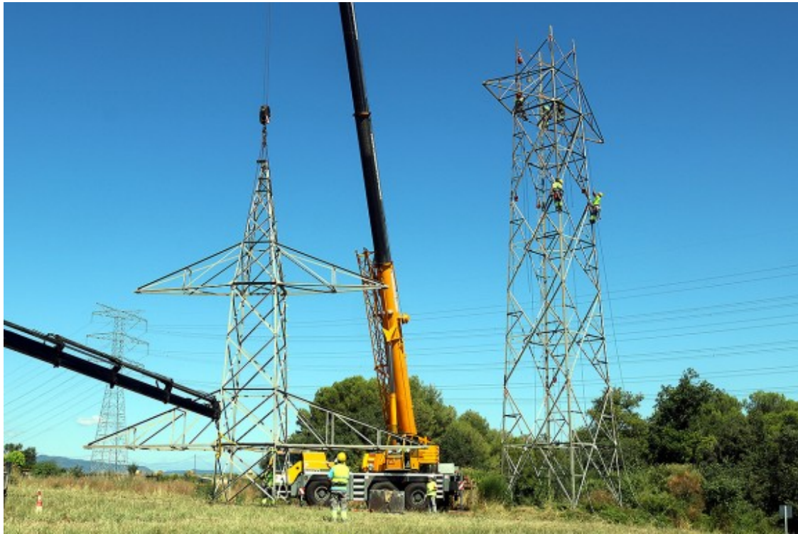
Desmantellant la torre de la línia de 220 kV aquest dilluns. Foto: ACN
