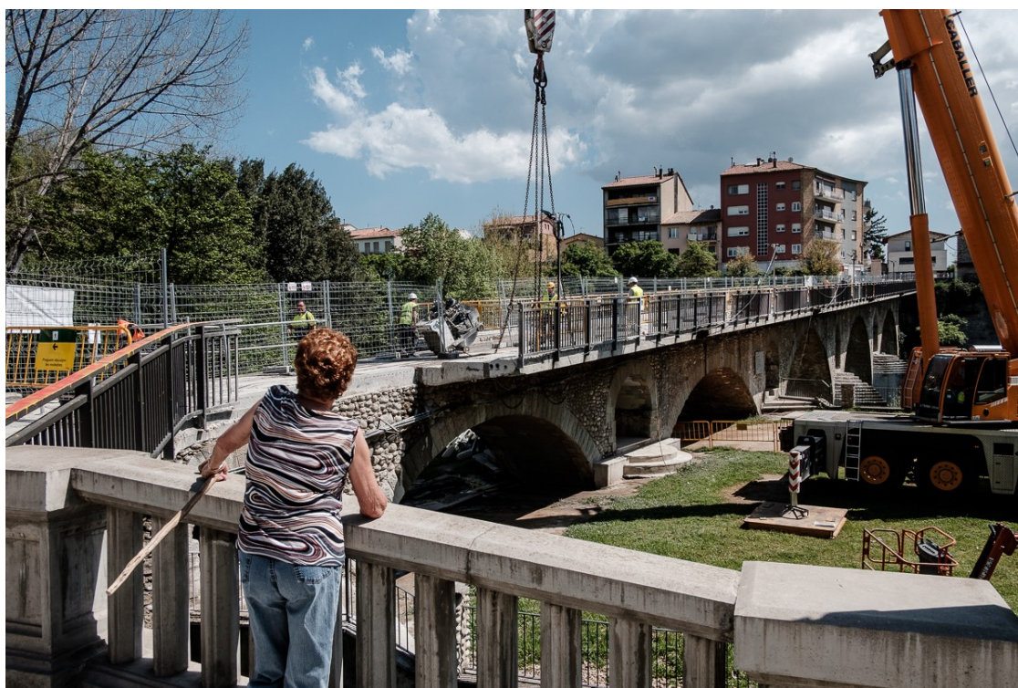
Obres del pont de Can Molas. | Adrià Costa
