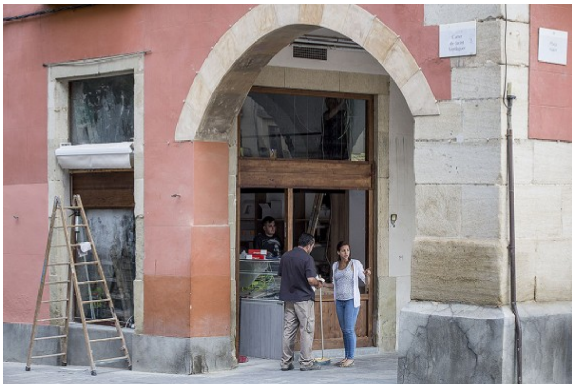
Obres del local on s'obrirà la nova botiga del Forn Franquesa. Foto: Adrià Costa
