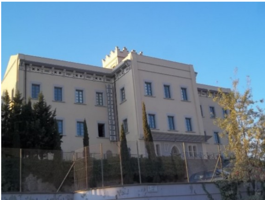
Edifici del Seminari de Solsona que ha acollit fins ara part de les instal·lacions del CTFC Foto: Ramon Estany
