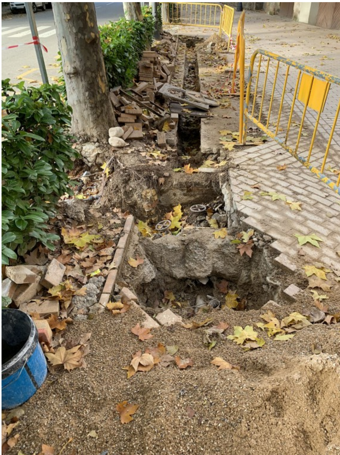
Les obres són a l'Av. Mare de Déu del Claustre
