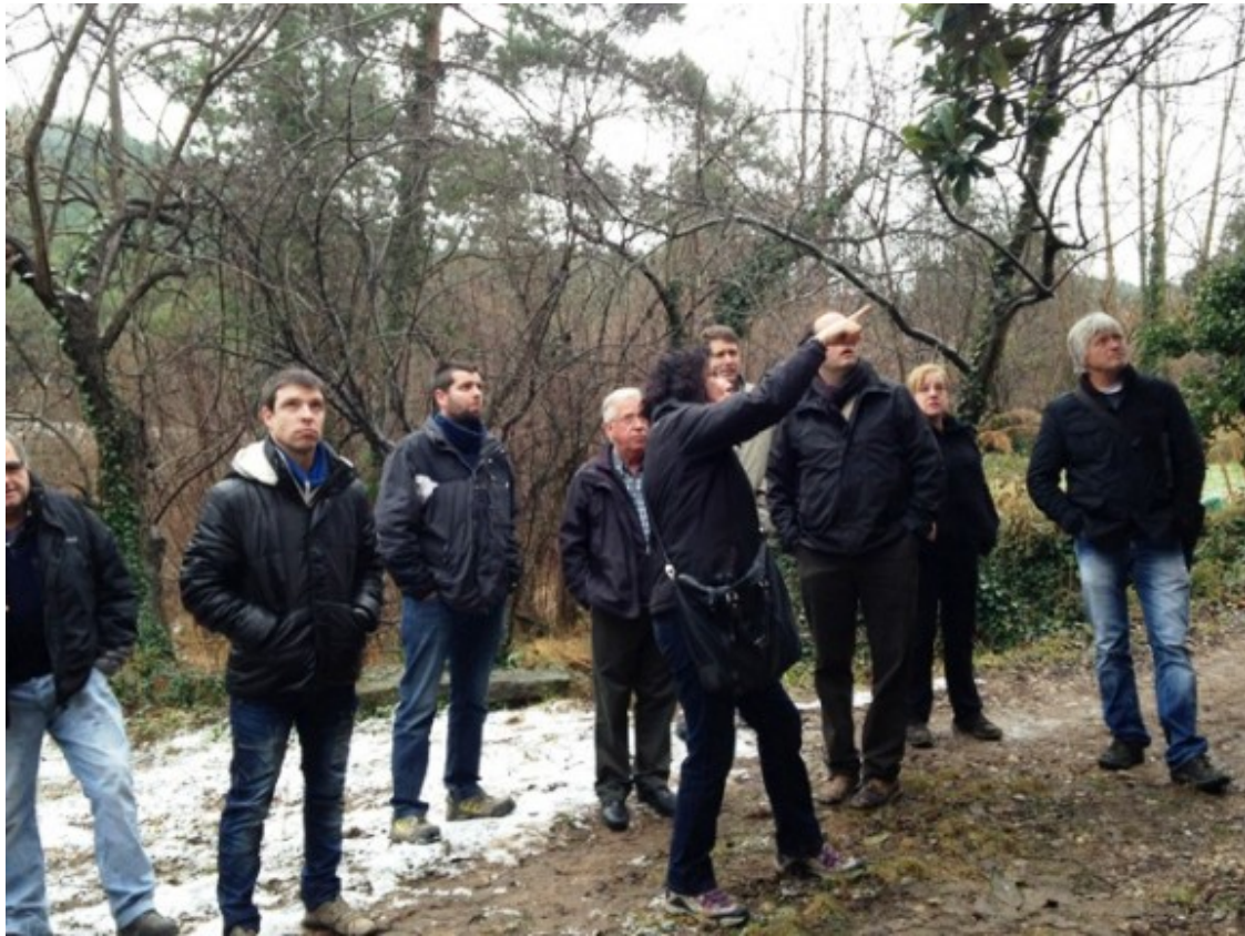
Solà, Vendrell, Casafont i Casellas visitant les obres amb l'arquitecta i els representants de l'empresa constructora
