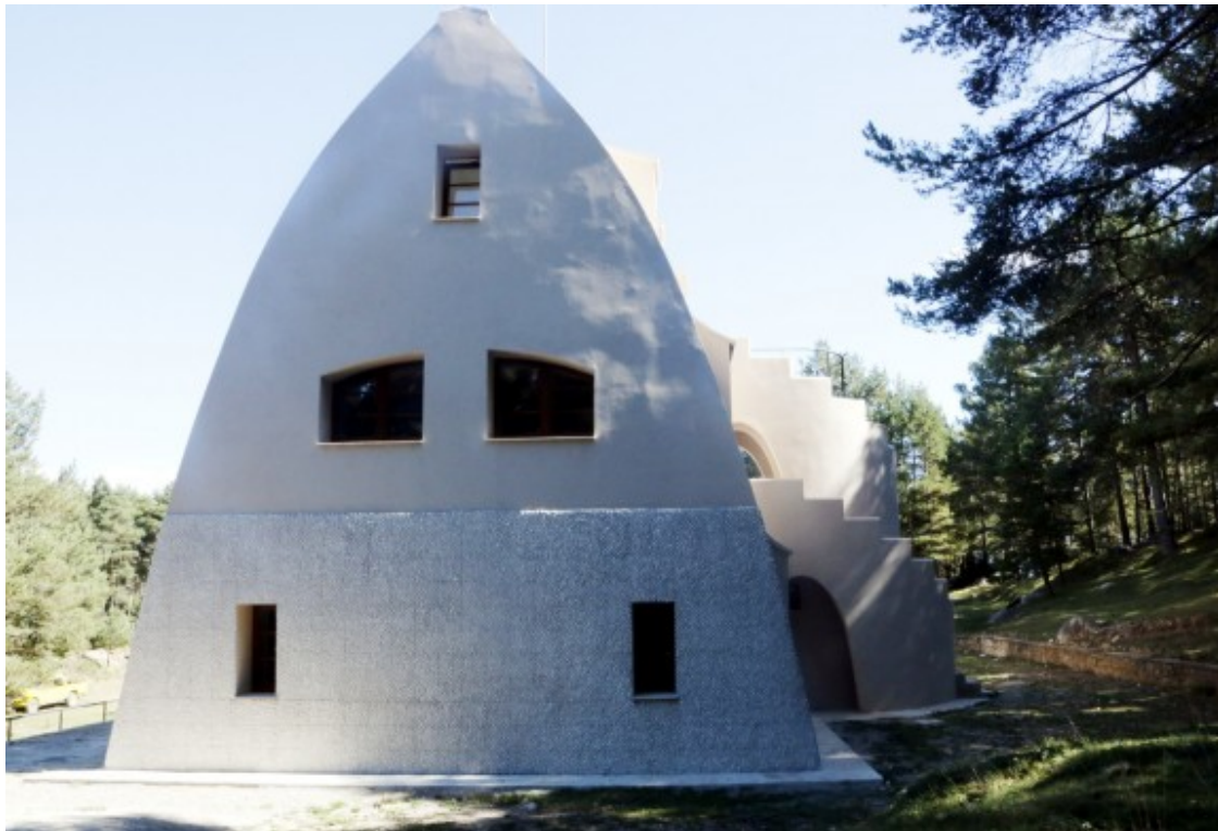
Un dels laterals del Xalet del Catllaràs, després de les obres. Foto: Gemma Aleman / ACN
