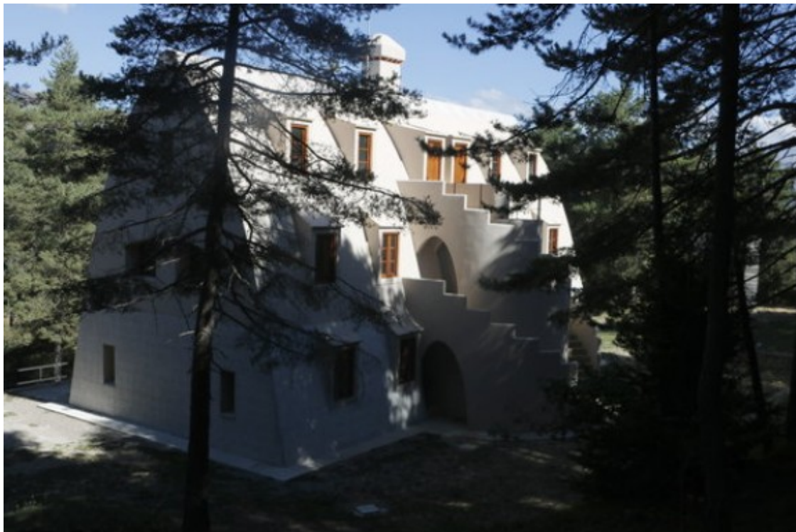
La cara frontal del Xalet del Catllaràs, després de les obres, vista des del bosc. Foto: Gemma Aleman / ACN
