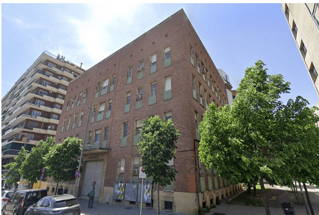
L'edifici dels antics jutjats de Granollers. | Google Street View
