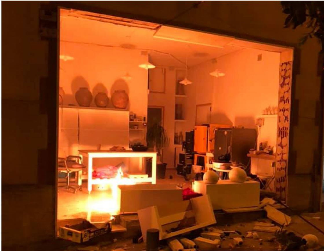
Un local de Sant Celoni destrossat per una explosió de gas butà | Xavier López Sastre
