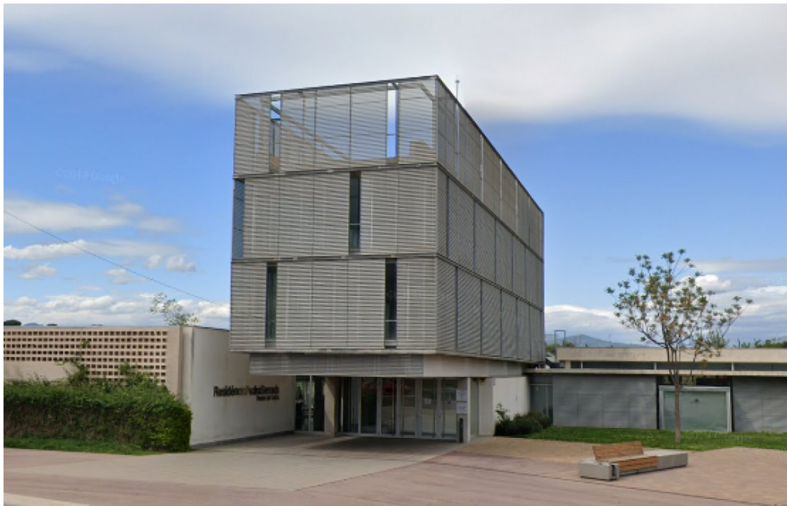
La residència Pedra Serrada, a Parets del Vallès | Google Street View
