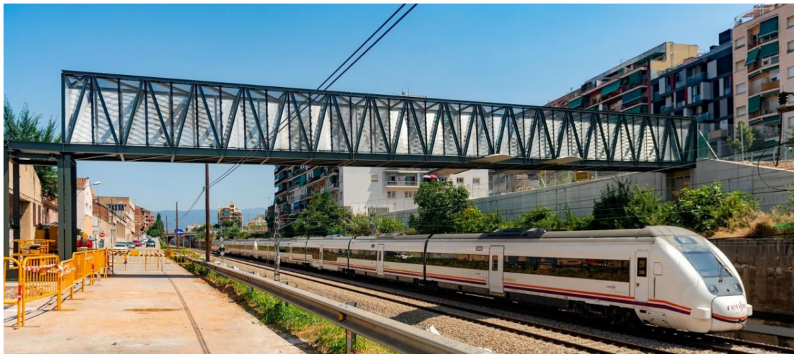
La passera, ja instal·lada sobre la via del tren. | T. Torrillas
