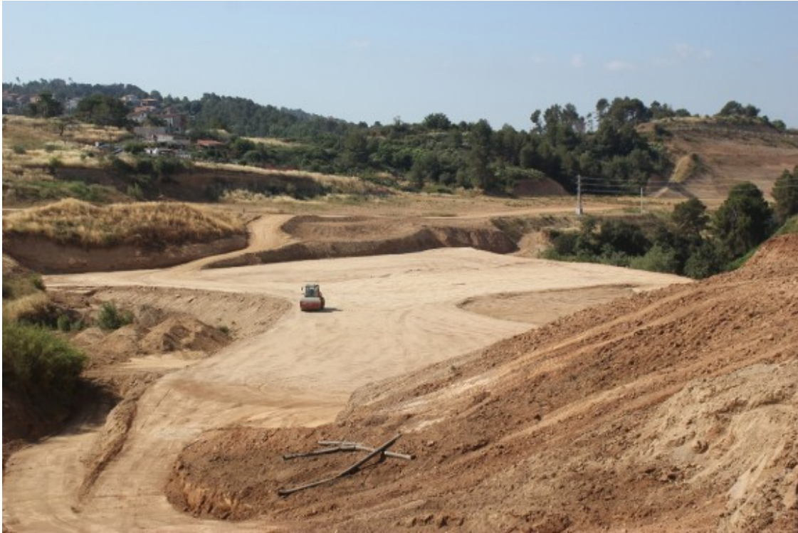
Obres de la B-40 al terme de Viladecavalls, a prop del futur enllaç amb la C-16. Foto: Albert Prieto
