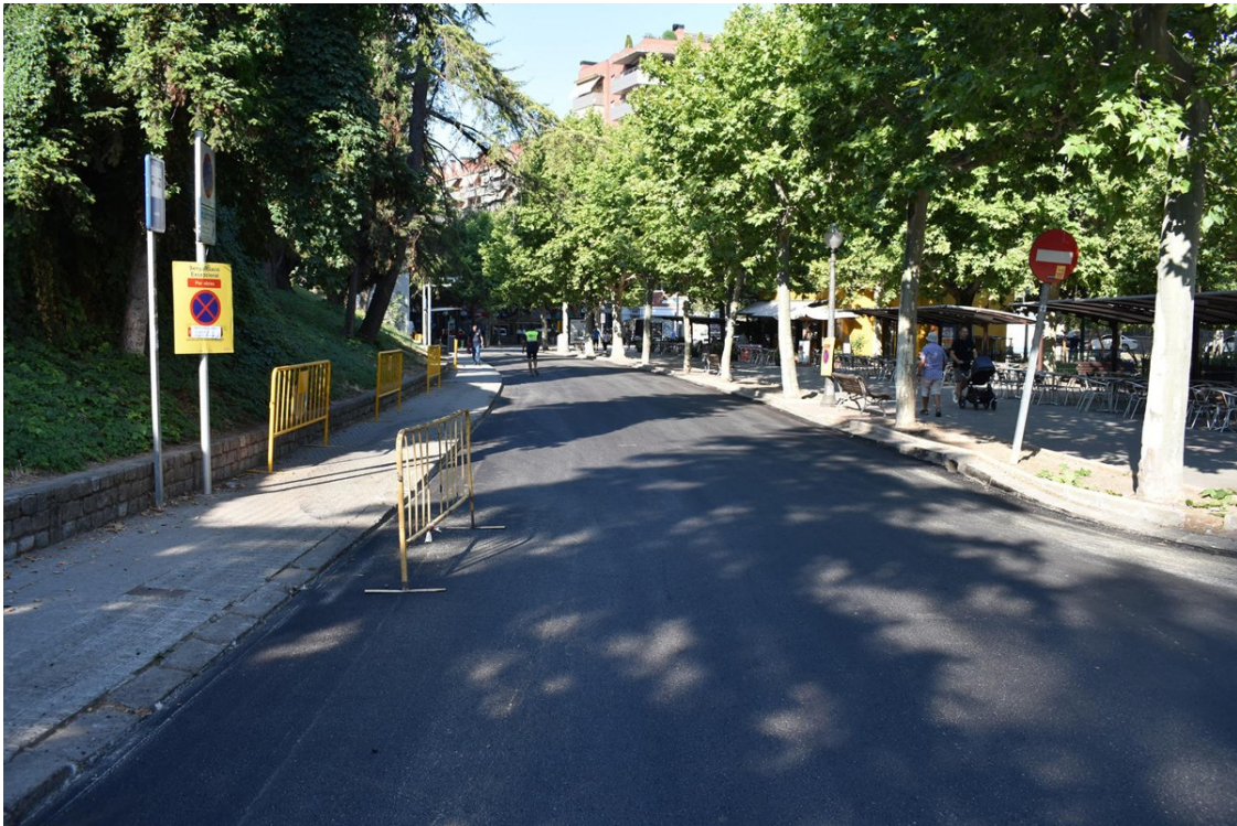
Treballs d'asfaltat al passeig Pere III amb plaça Espanya | AIM
