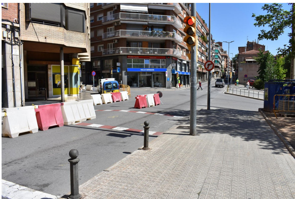
Obres a la cruïlla dels carrers Saclosa i Bruc | AjM
