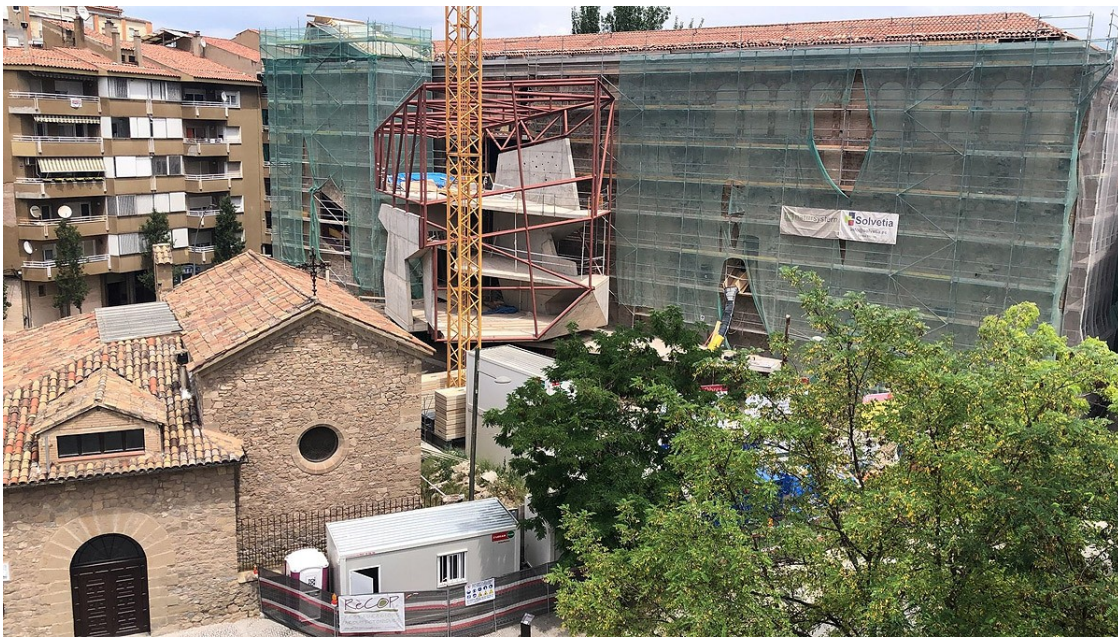
Obres al futur Museu del Barroc de Catalunya | MS
