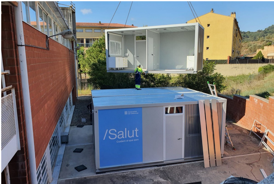
Instal·lació del mòdul de reforç d'atenció primària a Sallent | CatSalut
