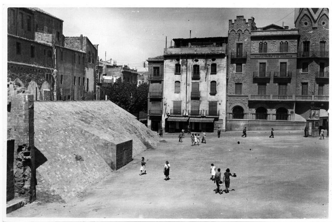
Refugi antiaeri a la plaça Sant Domènec de Manresa | Memòria.cat
