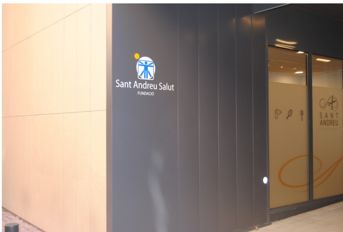
Accés a la residència de Sant Andreu de Manresa | AFT
